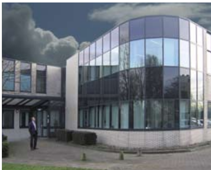
● Gebouw staat centraal bij facility management.
