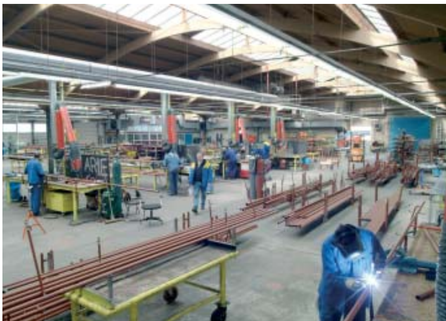
1. Prefab werkplaats BAM Techniek te Veenendaal.
